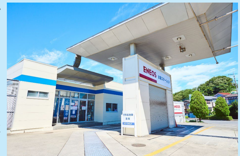
CO 2 フリー水素を製造・販売する横浜旭水素ステーション （水素ステーション内の太陽光パネルと水電解装置により、CO 2 フリー水素を製造・販売するのは国内初）
